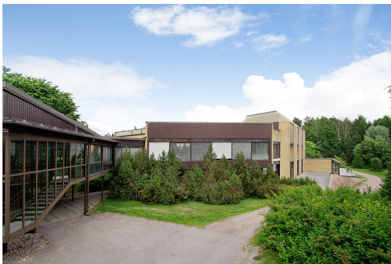
PÄÄRAKENNUS LOUNAASTA / HUVUDBYGGNAD FRÅN SYDVÄST
