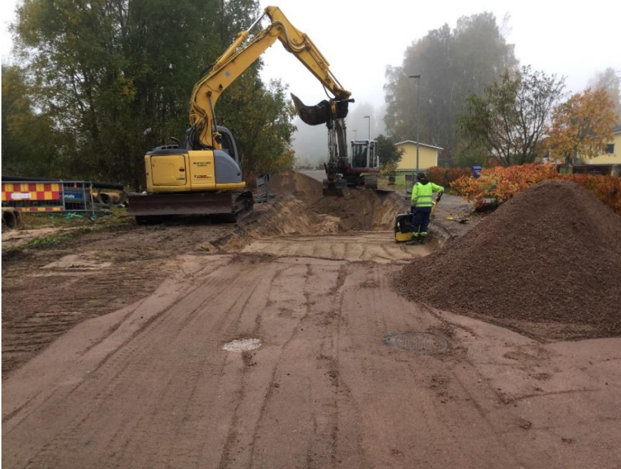
Pormestarinkadun saneeraus, Karjaa
