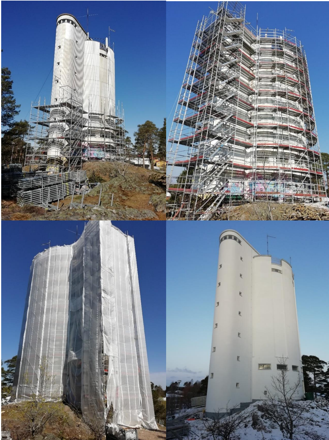
Karjaan vesitorni saneerauksen eri vaiheissa vuonna 2019
